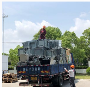
高空作业改善前
